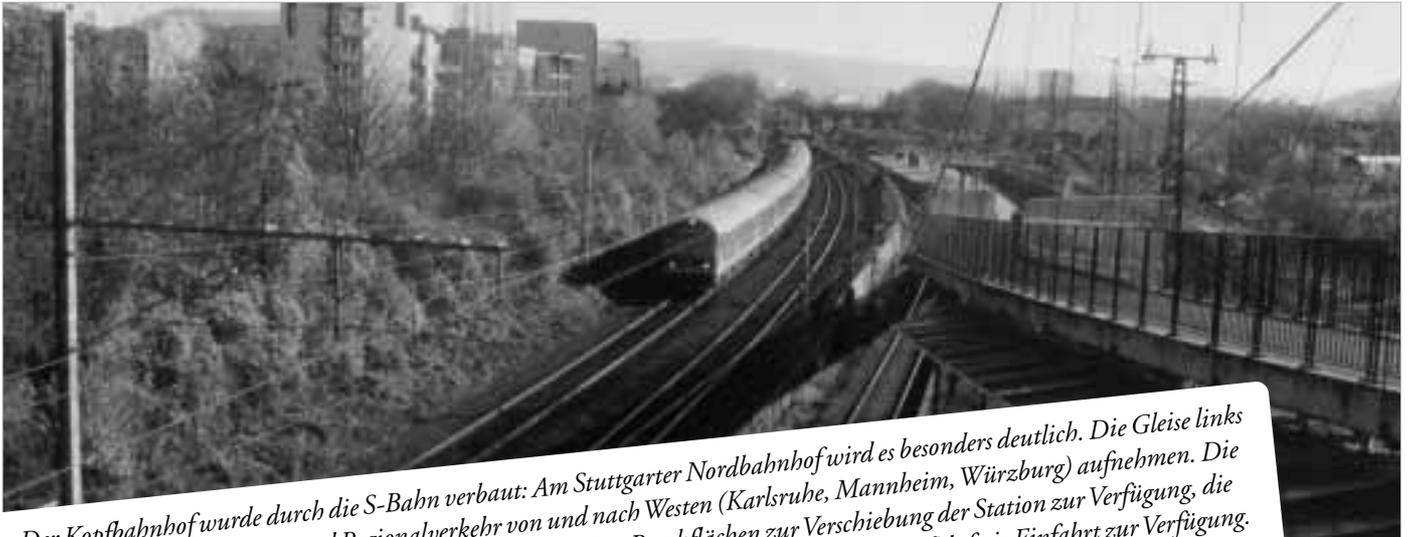
Der Kopfbahnhof wurde durch die S-Bahn verbaut: Am Stuttgarter Nordbahnhof wird es besonders deutlich. Die Gleise links müssen den gesamten Fern- und Regionalverkehr von und nach Westen (Karlsruhe, Mannheim, Würzburg) aufnehmen. Die S-Bahn-Station steht mitten im Gelände, rechts davon stehen Brachflächen zur Verschiebung der Station zur Verfügung, die früher dem örtlichen Güterbahnhof dienten. Danach stünden wieder vier Gleise für die konfliktfreie Einfahrt zur Verfügung.
