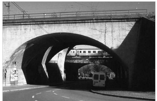
*In der Unterführung Ehmannastraße gut sichtbar: Die Gleise verlaufen in zwei Ebenen. Die dritte Ebene (Gleise Richtung Bad Cannstatt) läge parallel zur hier sichtbaren Straße. Damit lassen sich die Fahrwege entwirren und das Gleiswinkel vor den Bahnsteigen vereinfachen.*
