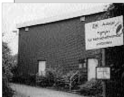
Das Stellwerk von Detmold.
