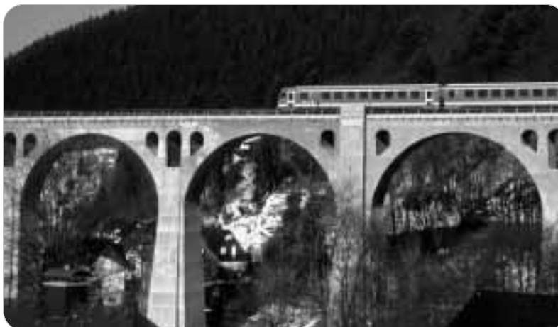
Das Willinger Viadukt: Die Sanierung war kein Neubau – also auch nicht als Neubau finanzierbar. Andere Finanzquellen mussten erschlossen werden.
