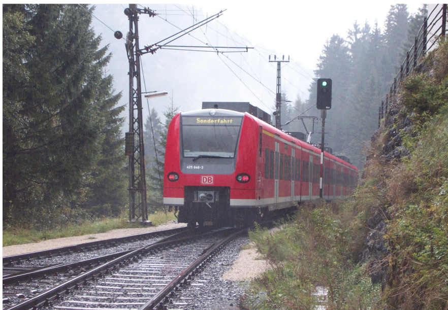
ET 425 als Sonderzug auf der wieder elektrifizierten Außerfernbahn (Foto: Matthias Wiegner)
