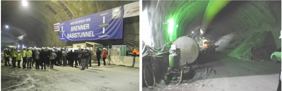
Besichtigung der Tunnelbaustelle (Bilder: Wolfgang Günther)
