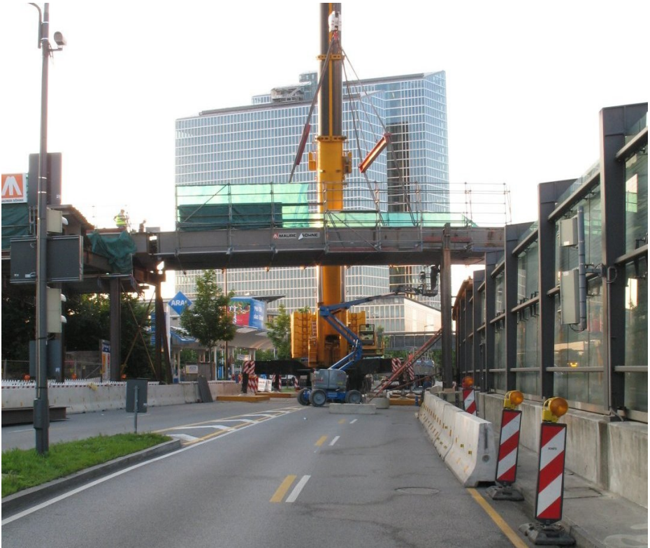
Einsetzen der Hängebrücke der neuen Tramlinie 23 über den Mittleren Ring in München. (Bild: Thomas Groetschel)
